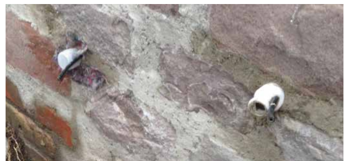
Verfüllpacker mit Entlüftungsschlauch, für Anschluss Schnellschnappverschluss | Injecteur de remplissage avec tuyau de purge, pour raccord de raccord rapide
